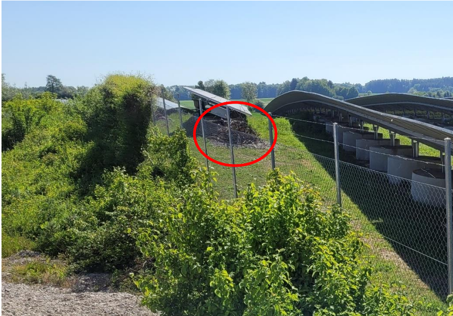
Abb. 9: Für die Fortführung des Deponiebetriebs angelegte Totholzhaufen im Bereich der bestehenden PV-Anlage
