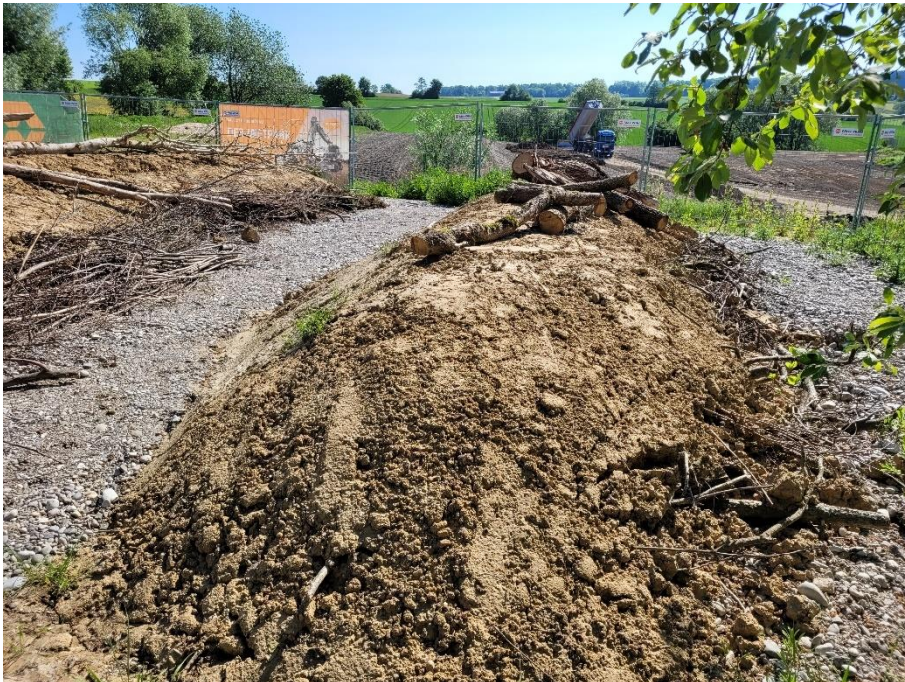
Abb. 8: Für die Fortführung des Deponiebetriebs angelegte Reptilienwälle im Bereich der im Bebauungsplan mit M1 gekennzeichneten Fläche
